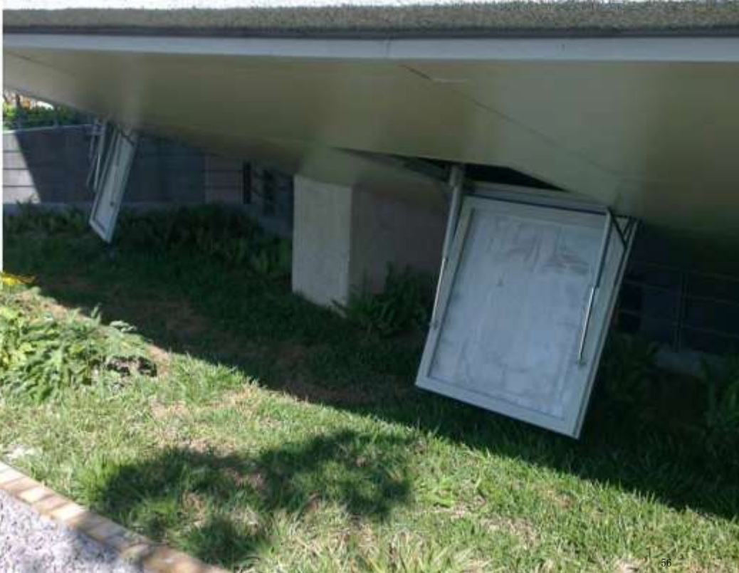
階梯教室浮力通風設計-引入低溫外氣減少空調耗能
