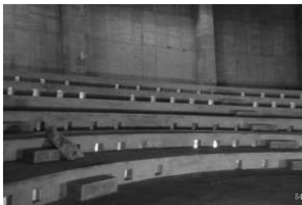
階梯教室浮力通風設計-引入低溫外氣減少空調耗能
